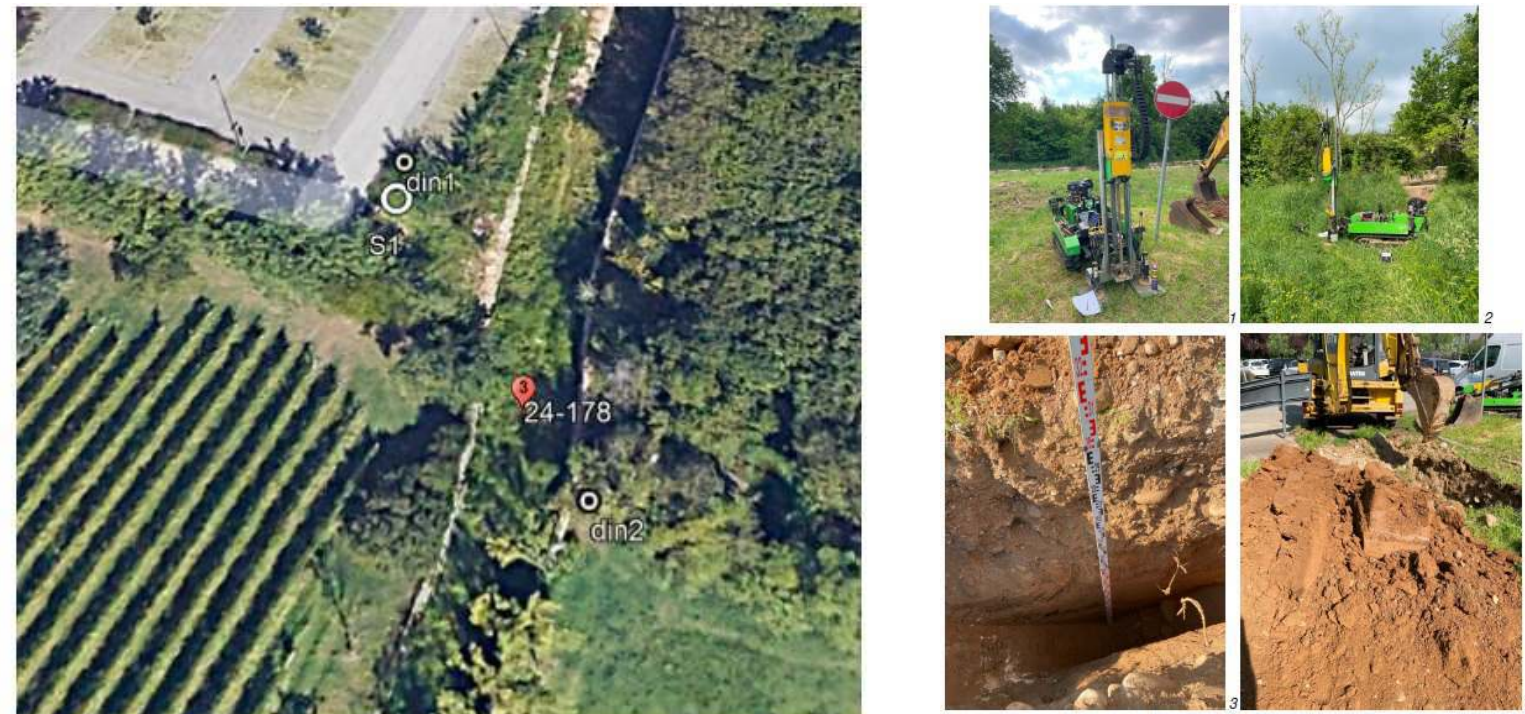
Fig. 5 - Posizionamento e vista stazione delle prove penetrometriche
